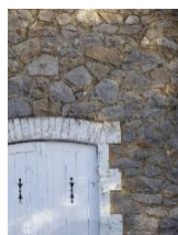
Pierres et briques. Contrevents en bois ajouré
