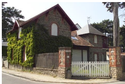
Saint-Hubert, 85 avenue des Lilas, allée de la Garde
