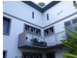
Fenêtres à cadre en surépaisseur.
