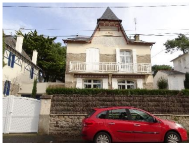
14, avenue de l'Amiral Courbet. Soledad puis Gracieuse. Paul Deligny, architecte. Vers 1927.
