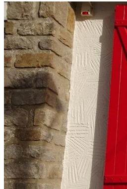
Granite et enduit à motif.
