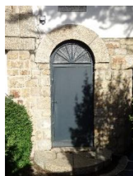
Porte en arc en plein cintre
