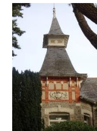
Toiture à double égout
