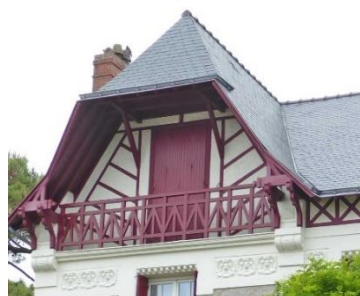
La couverture enveloppe généreusement le volume bâti ; le pan de bois fait décor
