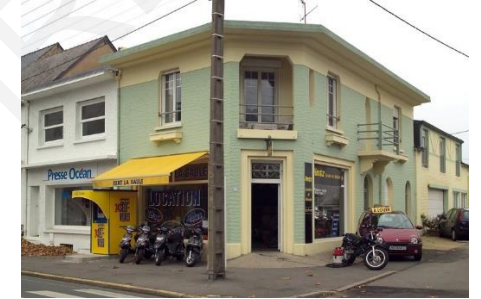
23 avenue Georges-Clémenceau ; 1-3 avenue des Bruyères
