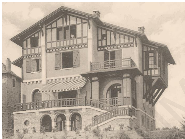
Villa « les Cigales » (1910) - Architecte J. GIRETTE
