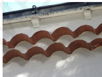
Génoise à deux rangs de tuiles canal
