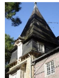
Toiture à double égout
