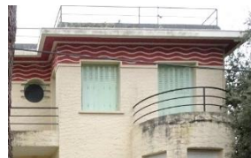
Frise en béton moulé
