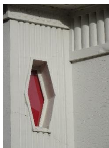
Décor en béton moulé et fenêtre hexagonales
