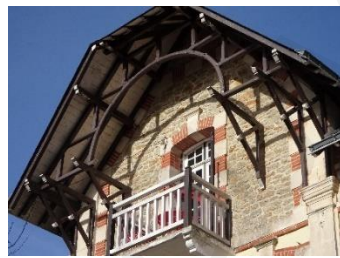
Pignon couvert. Ferme débordante, semi-circulaire.
