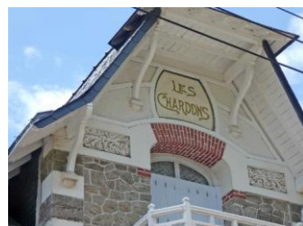
De forts débords de couverture, dont un effet de casquette en pignon, des consoles ouvragées
