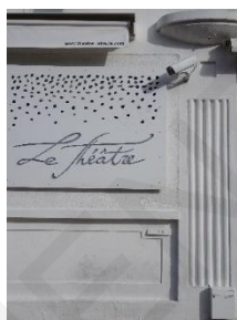
Motifs rudentés en béton
