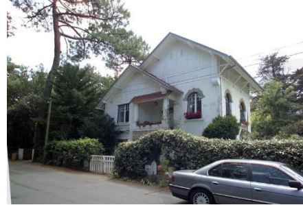
Rozen puis les Fontenils, 10 avenue de Châteaubriand
