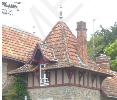
Une tour, surmontée d'un couronnement de poteaux en bois, tel un hourd, une lucarne passante étroite dans une toiture à très forte pente
