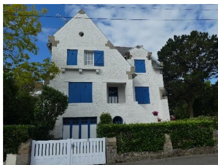
9 avenue Alfred Bruneau
