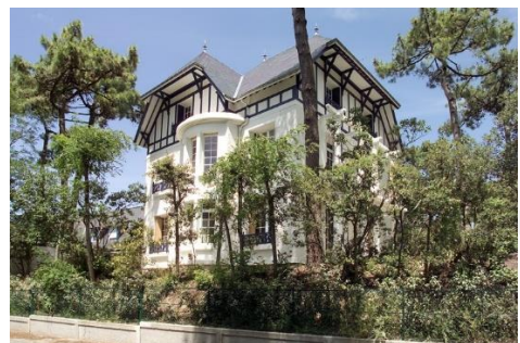
Les Colonnes, 2 avenue du Maréchal-Joffre, 1 avenue Guynemer
