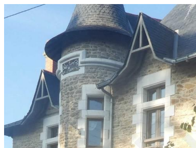
Une tour semi engagée, des fenêtres à croisée ; un bandeau très saillant contourne une baie
