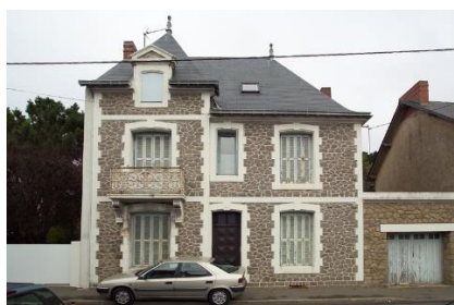
Alphonse Pierre, 9 avenue du Maréchal-de-Lattre-de-Tassigny
