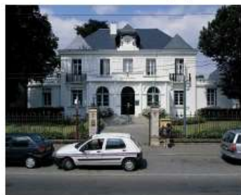
Hôtel des impôts, 235 avenue du Maréchal de Lattre de Tassigny
