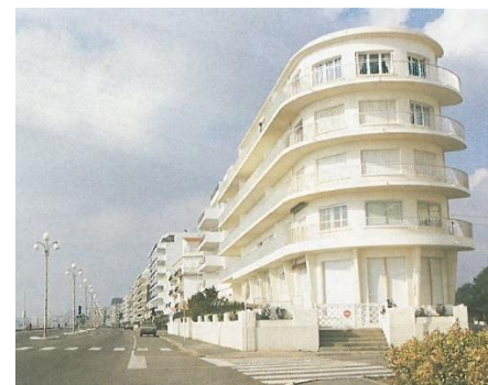
Le Floride, 8 bd de l'Océan, av Méricimée, 1950 : Architecte : P. Louis, Promoteur : Beaulande Source : Les villas de La Baule, C. David, S Ménoret
