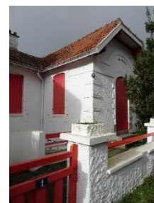
Enduit et briques
