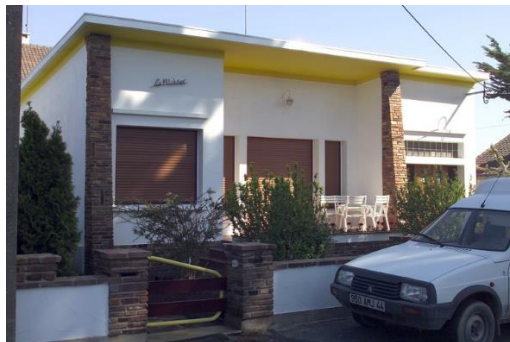
63 avenue du Général Berthelot
