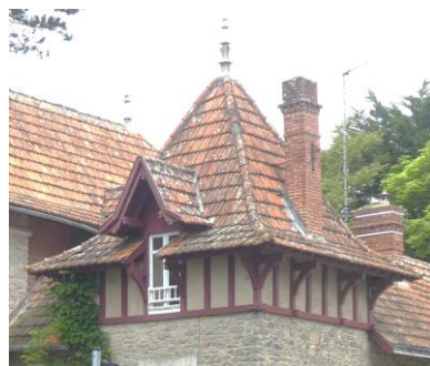
Une tour, surmontée d'un couronnement de poteaux en bois, tel un hourd, une lucarne passante étroite dans une toiture à très forte pente
