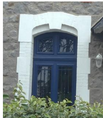
L'assouplissement esthétique de l'encadrement classique de la porte par le linteau courbe, avec un ressaut. La ferronnerie est très ornementée de circonvolutions
