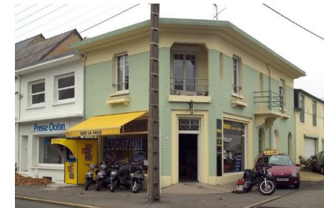
23 avenue Georges-Clémenceau ; 1-3 avenue des Bruyères
