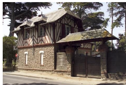
Gwel Armor puis Korrigan, 89 avenue des Lilas, allée de la Korrigan
