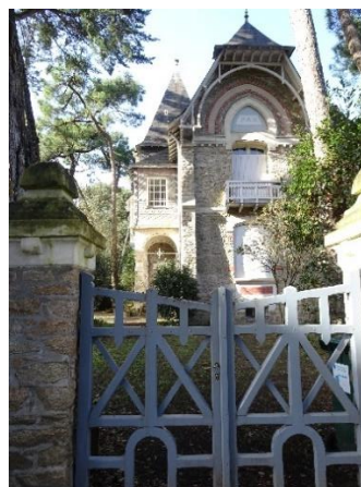
5, avenue Louis Pasteur. Pax. Georges Lafont, architecte. 1908.
