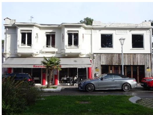
10, avenue Pavie. Adrien Grave, architecte. 1926
