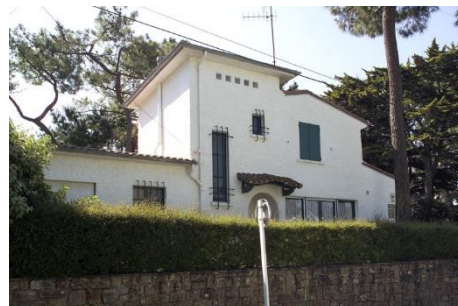
42 avenue du Général-Rodes, 31 allée de la Fauvette
