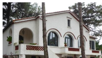
La terre-cuite contribue à l'ornementation de la façade
