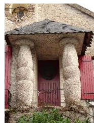
Colonnes en faux granite
