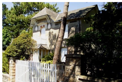
La Falotte, 14 avenue de la Noue, 16 avenue des Hirondelles
