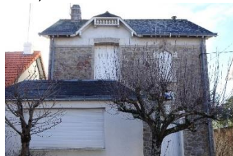
24, avenue des Ormes. Antonin Viale, architecte. Vers 1913. Véranda ajoutée vers 1930. Tradition inventaire
