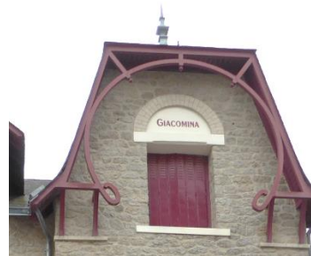
La charpente apparente assure la triangulation de la rive de toiture par un grand cercle
