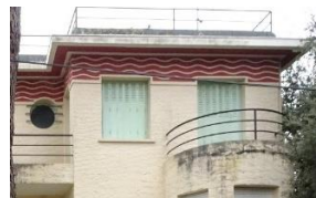
Frise en béton moulé
