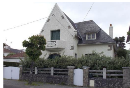
22 avenue de la Tour-Rouge
