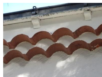
Génoise à deux rangs de tuiles canal
