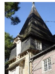
Toiture à double égout
