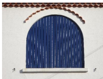
Fenêtre en plein cintre
