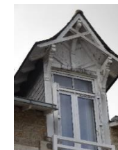
Lucarne à ferme débordante
