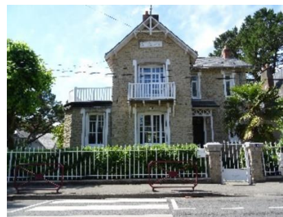
Exemples de murs de clôture protégés
