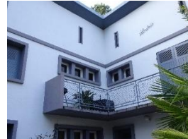
Fenêtres à cadre en surépaisseur.
