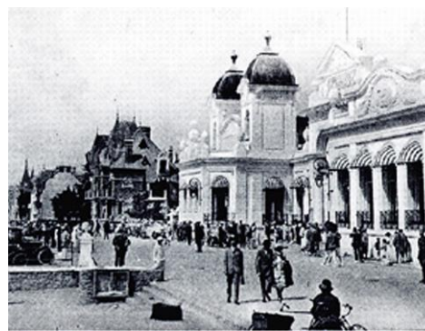
1924 : Construction du casino
