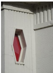
Décor en béton moulé et fenêtre hexagonales
