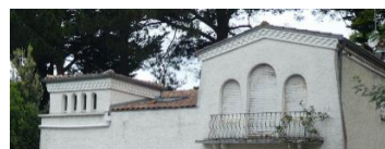
L'architecture perpétue l'influence romaine du Midi, architecture de pignons ornés ici par une génoise
