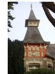
Toiture à double égout
