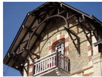
Pignon couvert. Ferme débordante, semi-circulaire.
