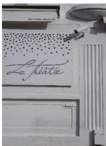
Motifs rudentés en béton
