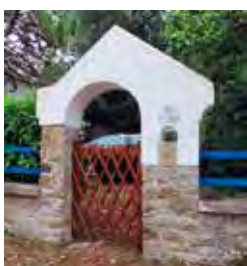
Portail surmonté d'un fronton.
