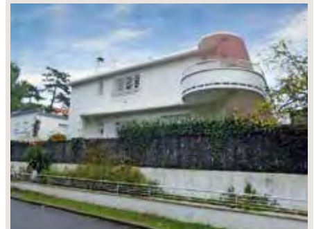
Atlantide, vers 1950, Pierre Bourineau architecte
