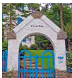
Portail en pierre et maçonnerie enduite en forme de fronton.
