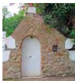
Portail néo-breton en arc plein cintre en pierre.
