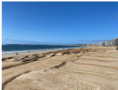
TRAVAUX Nivellement de la plage de La Baule 2025
